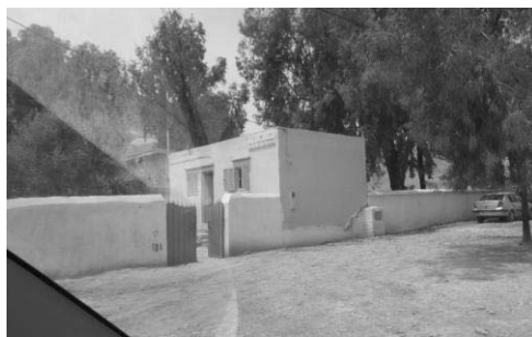
Groupe scolaire Traiba situé au centre
