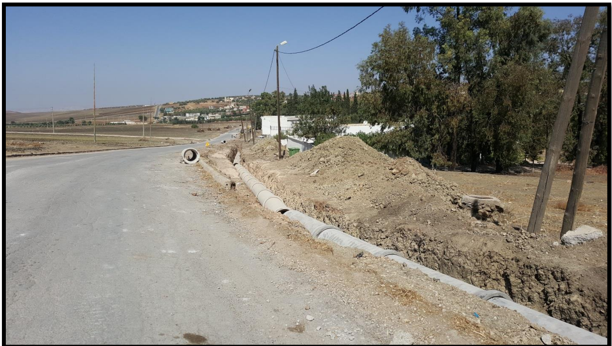
Photo 6 : Travaux d'aménagement de l'avenue du 3 Mars (assainissement)
